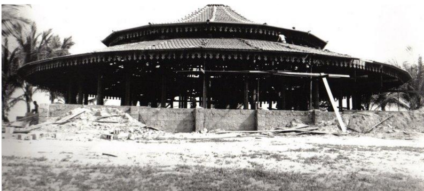
Figura 4. Construção do Clube Jacarandá
