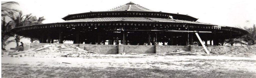
Figura 4. Construção do Clube Jacarandá
